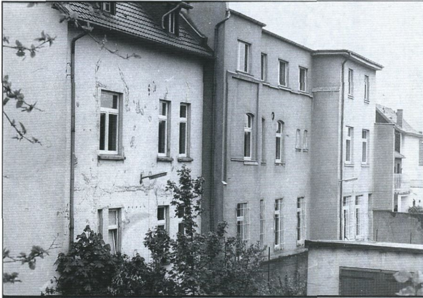
Abb. 19: Polizeigebäude, Häuser 15 und 13 (Hofseite).
