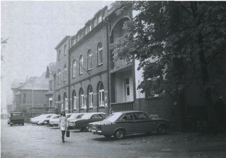
Abb. 18: Polizeigebäude, Häuser 13 – 15 (Straßenseite) um 1960.
