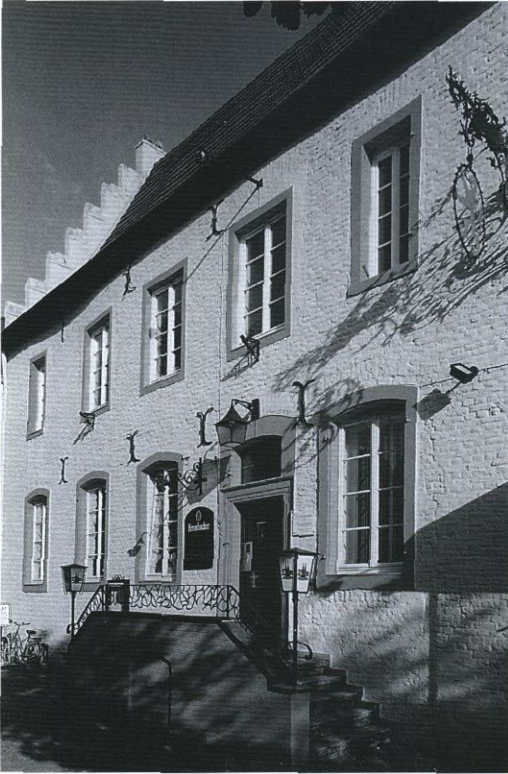
Abb. 3: Haus Hauptstraße 71 (Foto: Stadtarchiv Bergheim)
