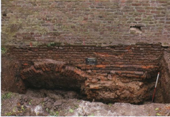
Abb. 8: Bergheim. Stadtmauer. Punktfundament mit Entlastungsbogen. Foto: Fa. Goldschmidt Archäologie & Denkmalpflege, Düren.
