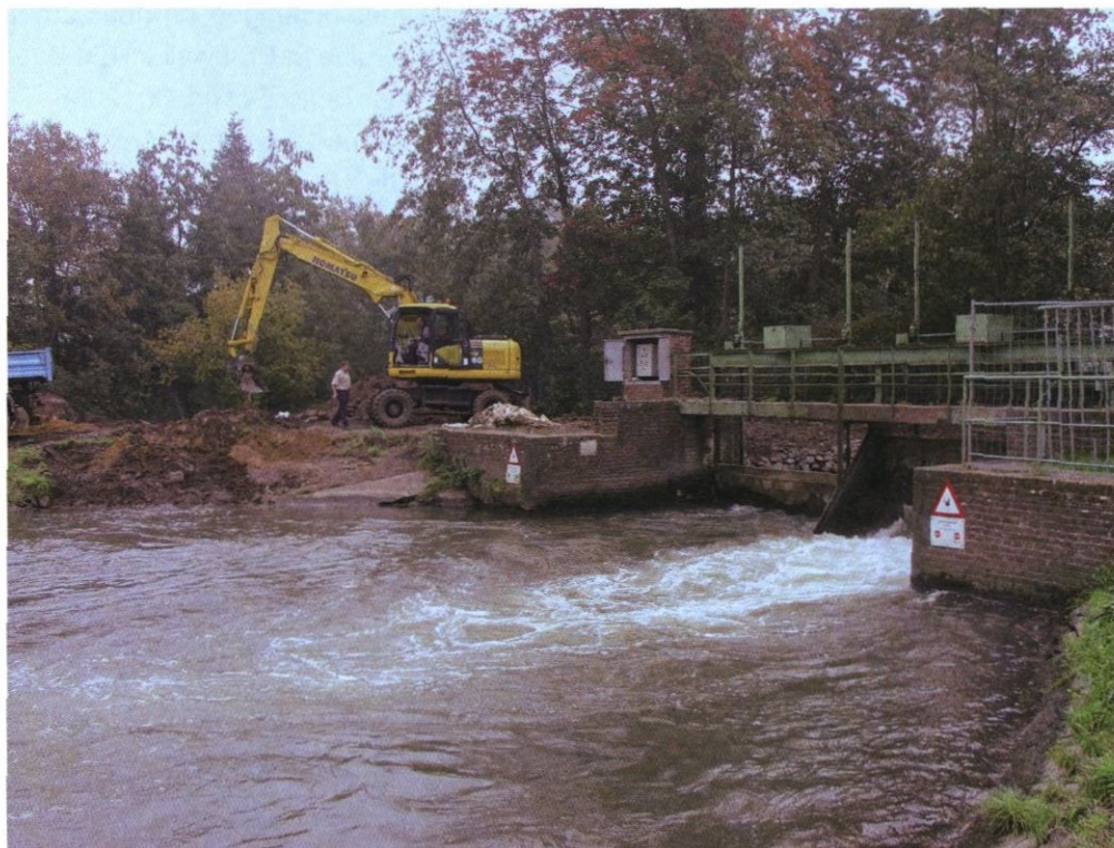
Abb. 13: Bergheim-Zieverich. Bau eines Umflutgerinnes in der Erfttaue. Foto: J. Altmiks, LVR-Amt für Bodendenkmalpflege.
