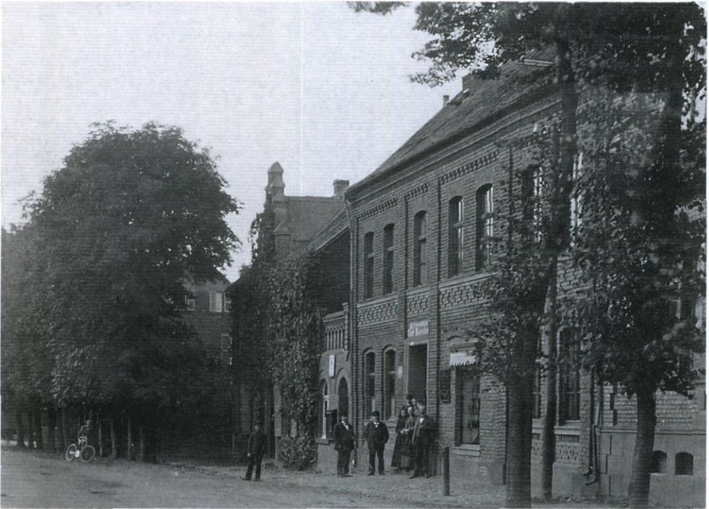
Abb. 12: Haus Nr. 26 vor dem Umbau etwa 1890 (Foto: Familie Rößler, Bergheim)
