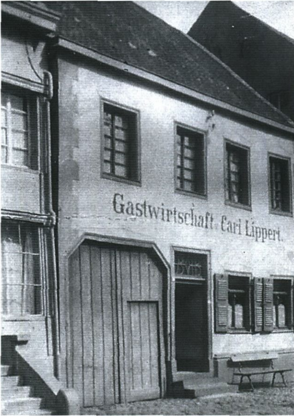
Abb.10: Gastwirtschaft Lippert um 1900. Das Fachwerk trägt einen Verputz. Neben der Türe ist ein Hoftor zu sehen, das beim Umbau 1928 verschwand. (Foto: Karl Lippert)
